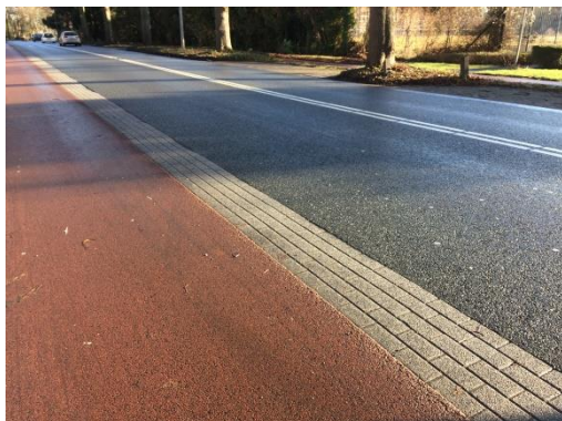
Figuur 2 – beklinkerde goot als grens tussen rijbaan en fietspad
