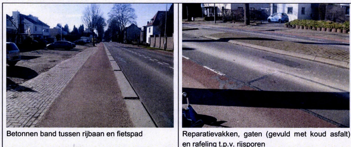
Figuur 6 Voorbeelden van schades op de Tongerseweg – sub-vak 2 t/m 5
