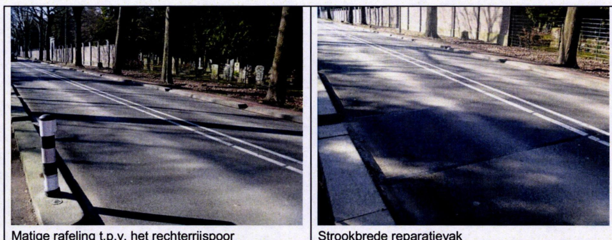
Figuur 5 Voorbeelden van schades op de Tongerseweg – sub-vak 2 t/m 5
