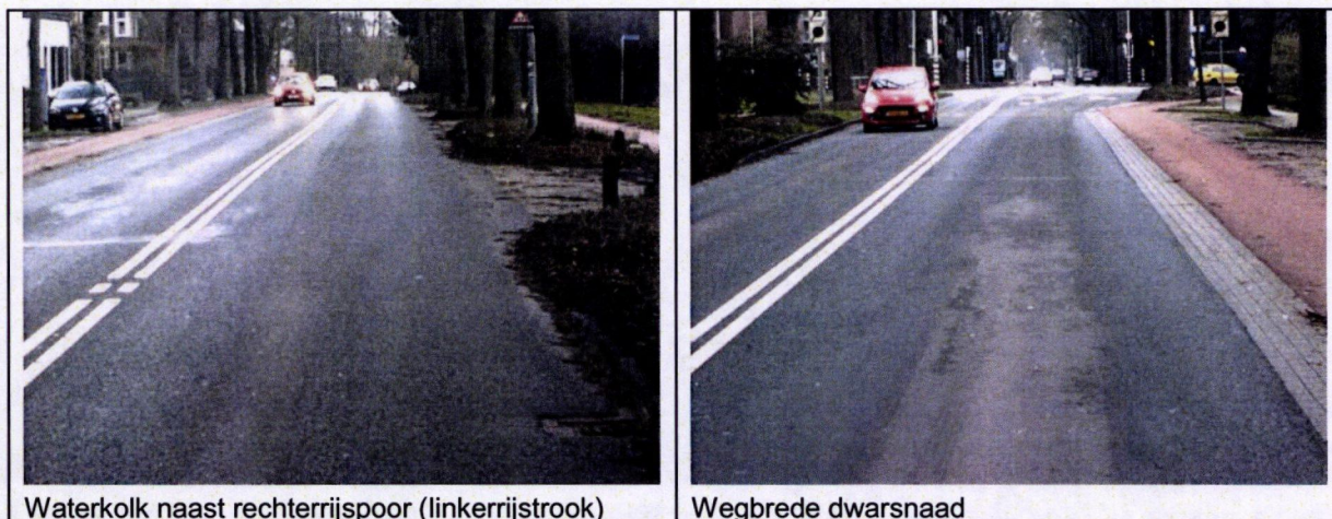
Figuur 4 Voorbeelden van schades op de Tongerseweg – sub-vak 1
