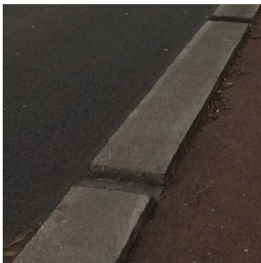
Figuur 1 – verhoogde wegmarkering van beton
